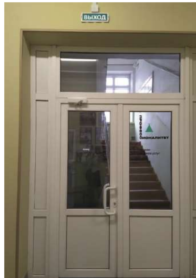
Рис. 4 Выход на лестничный марш в зоне 1-го этажа
