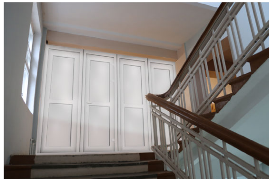
Лестница выход на 2 этаж
