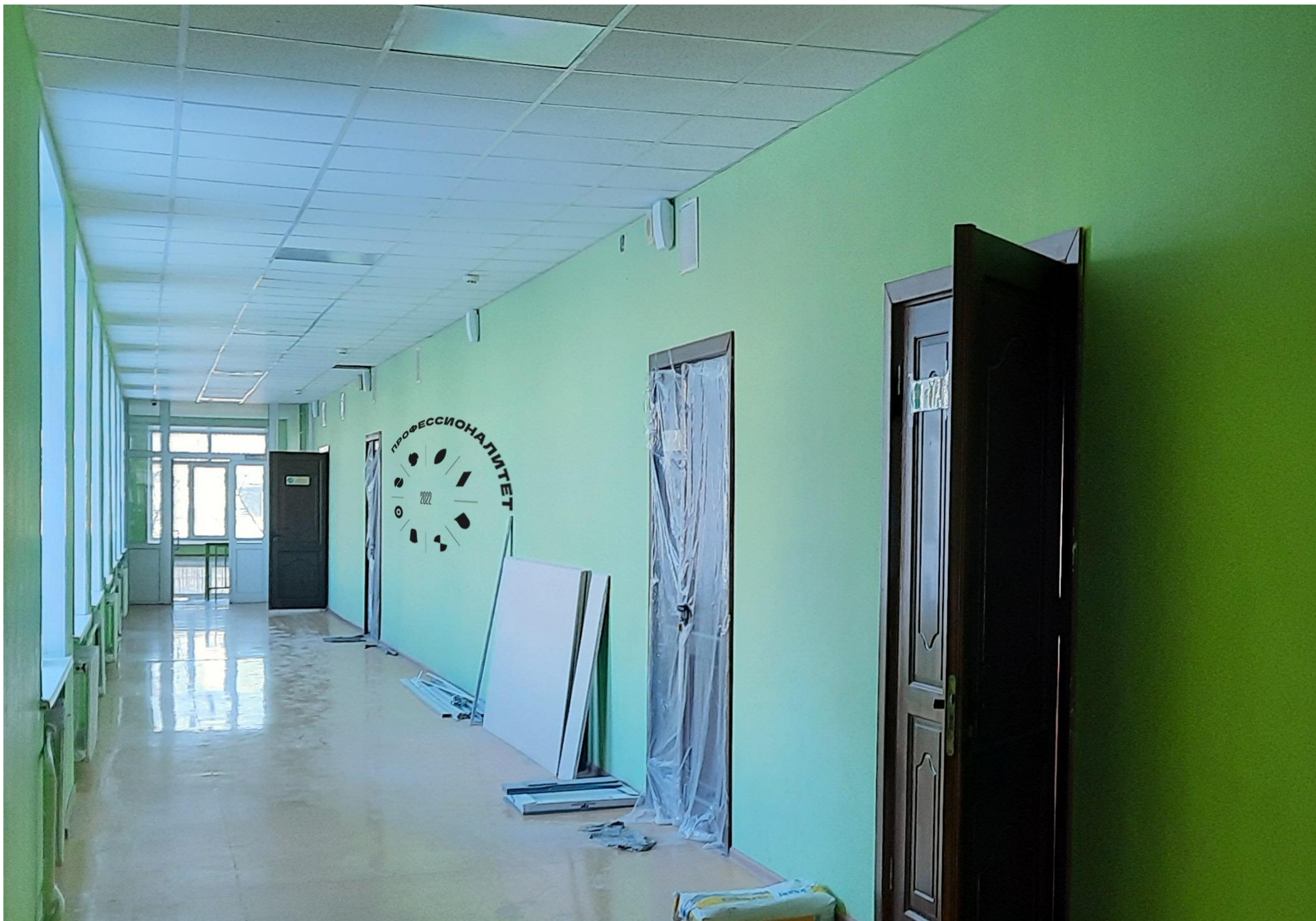
КОРИДОР 2-го ЭТАЖА
